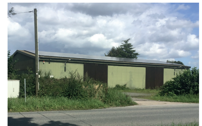
beispielhafte Installation einer Photovoltaikanlage in Braak, B2K und dni, 2021
