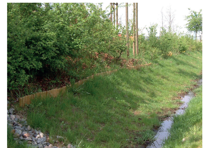
beispielhafte naturnahe Entwässerung, B2K und dni, 2021
