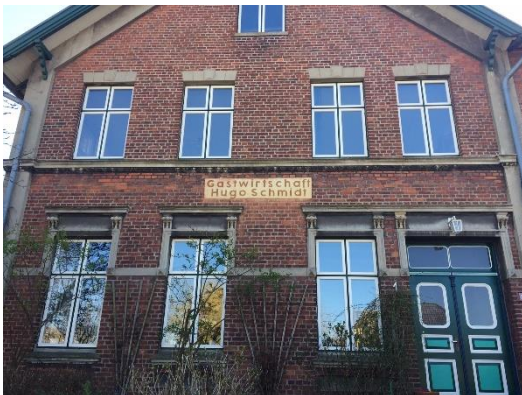
Abb.: ehemalige Gastwirtschaft, jetzt Wohnhaus
