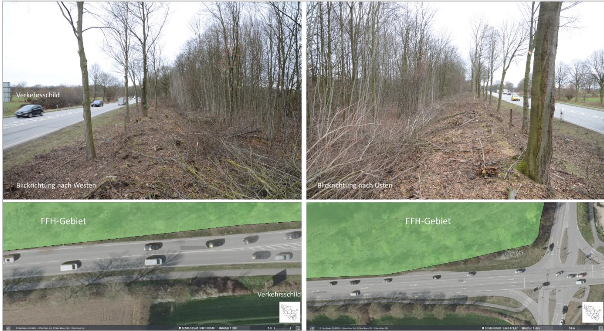
Abb. 5: Beschaffenheit des Streifens im Eingriffsbereich Quellen: Fotos: KifL (14.03.2018); Lage des FFH-Gebiets: LLUR
