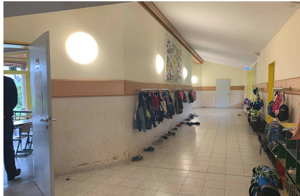
Garderoben / Flur, Erweiterungsbau ca. 20 Jahre
